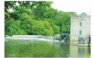
Barrage et microcentrale électrique de Corçu
