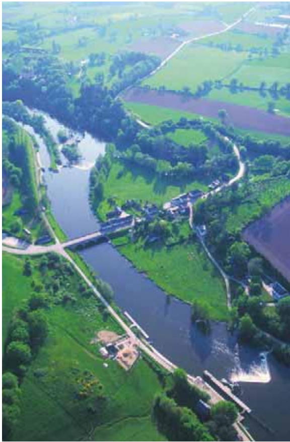
Le pont de Montgiroux avec le barrage à écluse du Bas-Hambert
