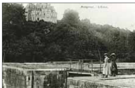
L'une des écluses du canal de navigation au début du XX e siècle
